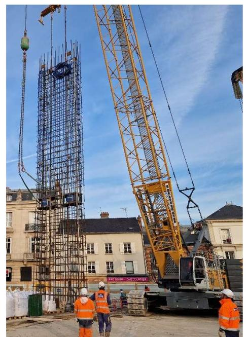
Installation de la cage d'armature d'une barrette équipée de 2 cellules O-Cells
